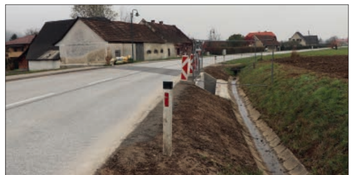
Die „Streichwehr“ in der Kapellenstraße
